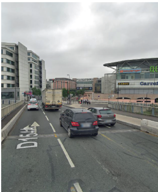
Le débouché du Pont Nelson Mandela
