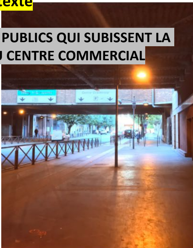
La rue Westermeyer, caractère routier et passage en ponts du centre-commercial Quai d'Ivry
