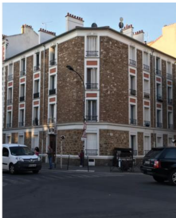
L'échelle de la rue : R+3 à R+5
