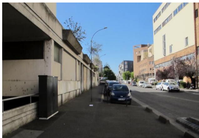
La rue Jules Vanzuppe, des RDC fermés sur la ville
