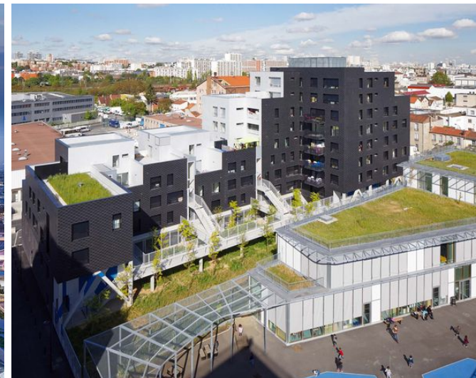
Ivry-Confluences, strates habitées, réappropriation du matériau brique - Atelier Dupont
