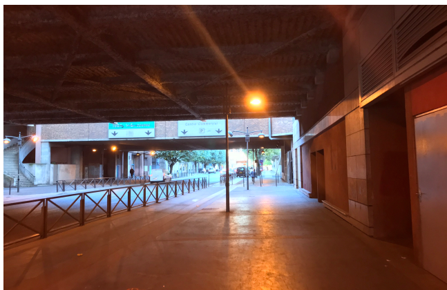
La rue Westermeyer, caractère routier et passage en ponts du centre-commercial Quais d'Ivry
