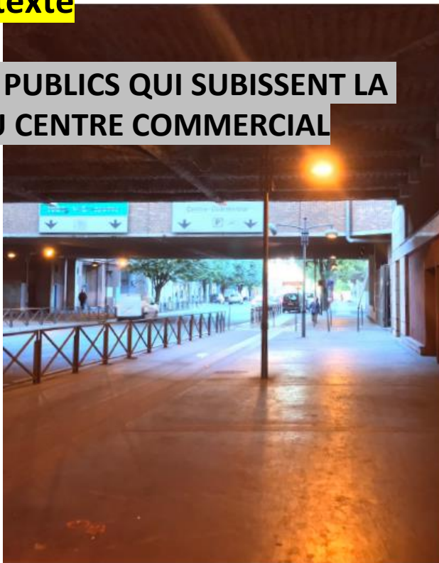
La rue Westermeyer, caractère routier et passage en ponts du centre-commercial Quai d'Ivry
