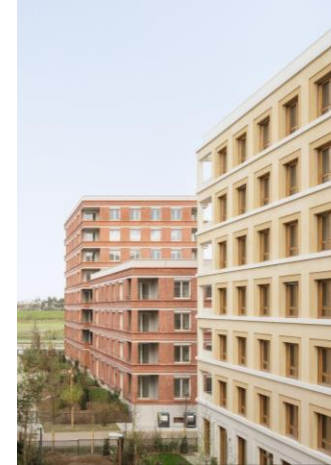
Ref - Village des médias - Hardel & Le Bihan Architectes
