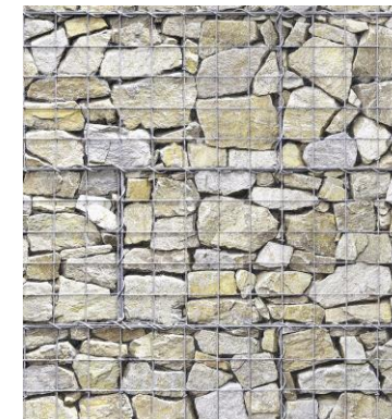
Gabillon en RDC de béton de réemploi
