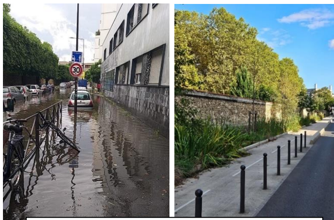
Rue Carnot, avant et après installation de la noue
