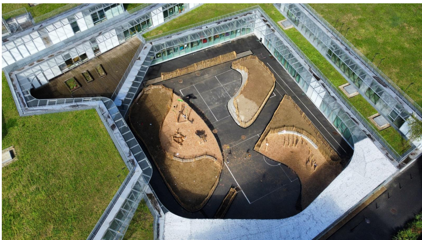
Une de deux premières cours végétalisées à Ivry-sur-Seine, la cour élémentaire du groupe scolaire Rosalind Franklin (avant plantations)
